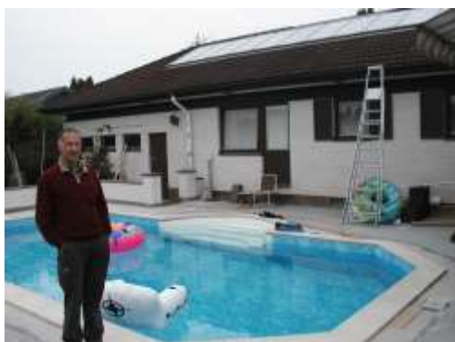
LESOL 3+, 19 m 2 , 12 moduler, värmer 750 L soltank och pool hos Mats Lindfors i Västerås. Ger varmvatten och poolvärme under badsäsongen och husvärme och varmvatten övrig tid.
